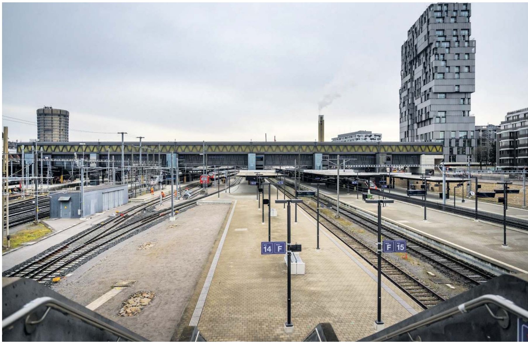
L'extension de la gare de Bâle illustre la manière dont le ministre des Transports entend procéder à l'avenir pour les projets ferroviaires: «Nous réservons déjà les fonds pour l'extension à Bâle, mais nous ne présenterons ce projet au parlement que lorsque les plans détaillés seront disponibles.» KEYSTONE
