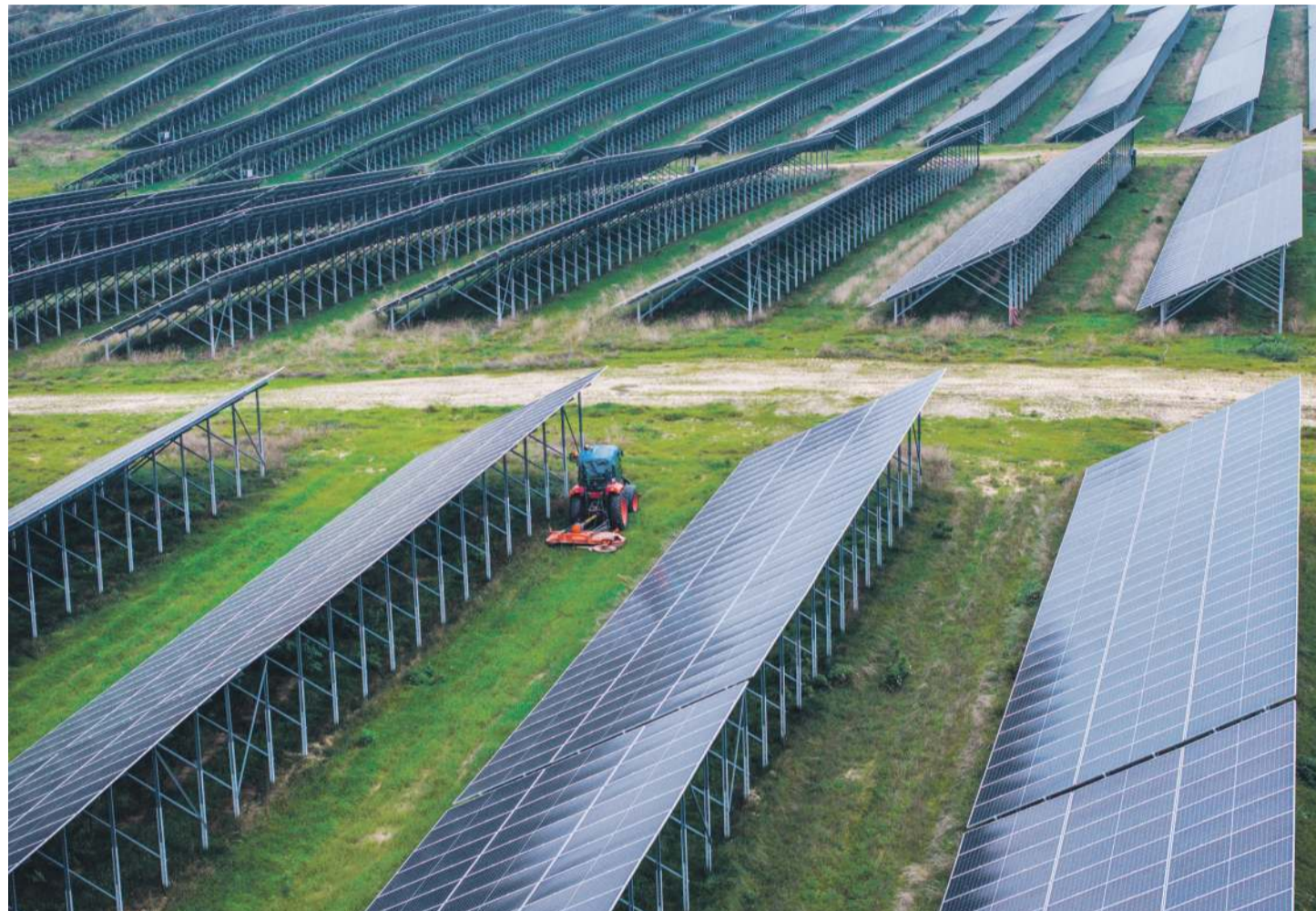
Centrale agro-photovoltaïque en Allemagne disposant de panneaux repliables pour les travaux agricoles. En France, jusqu'au début des années 2020, la production photovoltaïque dans les champs était assurée par des panneaux fixes au sol ne permettant aucune activité agricole. KEYSTONE
