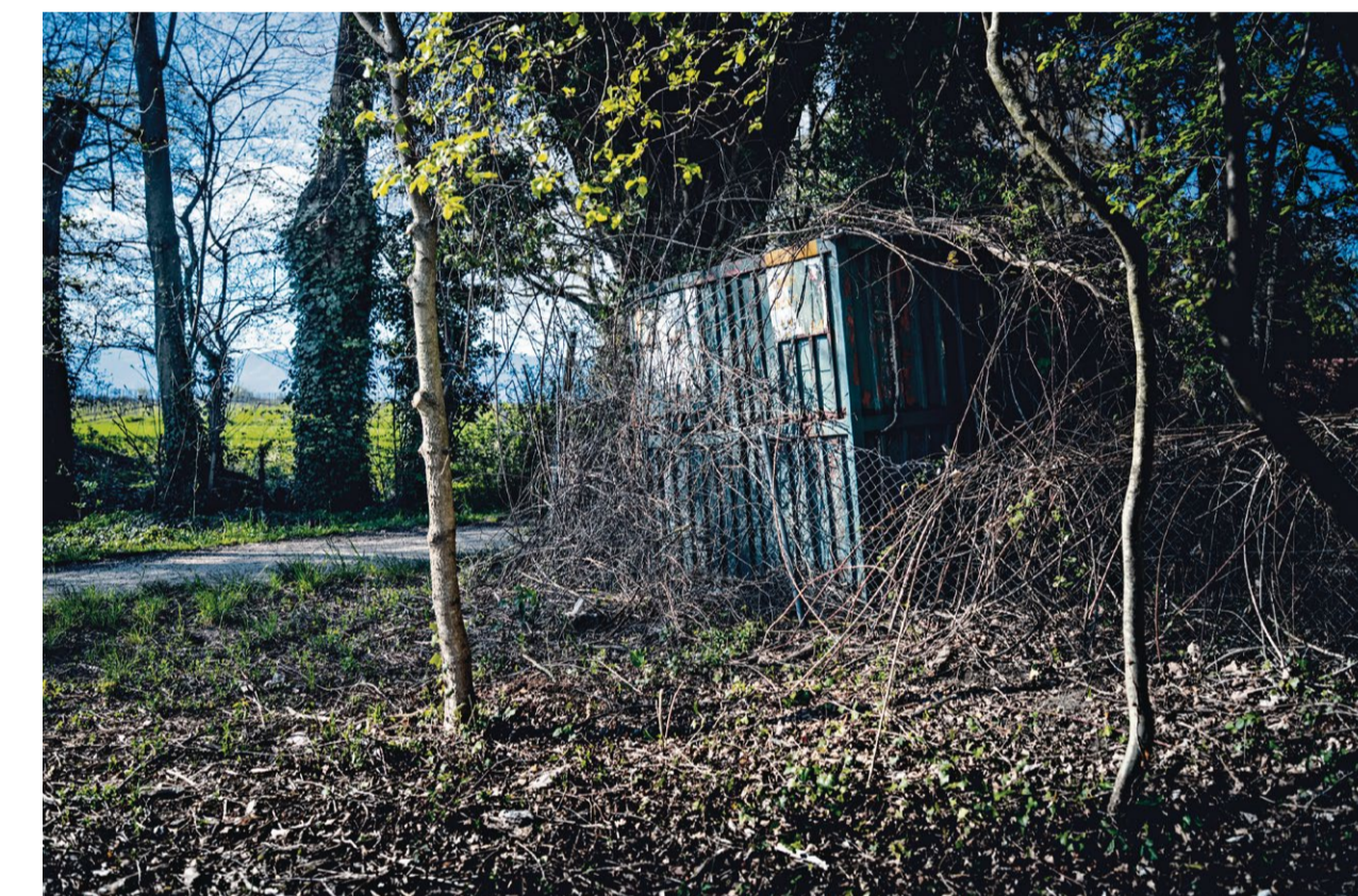
Dans la campagne genevoise, entre Choulex et Puplinge. Piscines, couverts pour véhicules ou vérandas: de petites constructions bâties illégalement sur des terrains situés en zone agricole pourraient bientôt connaître une seconde vie sans crainte d'un retour de bâton des autorités. (PHOTOS: 7 AVRIL 2026)
