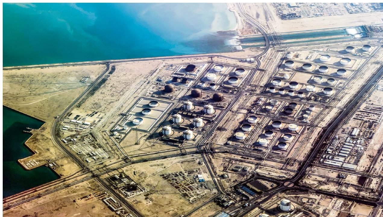
Des installations de gaz naturel liquéfié (GNL) à Ras Laffan, au Qatar, ont été endommagées en mars par des frappes iraniennes. Environ 4% des importations totales de gaz de l'Union européenne provient du Qatar (8% pour le GNL). (25 FÉVRIER 2026/HANNIBAL HANSCHKE/EPA)
