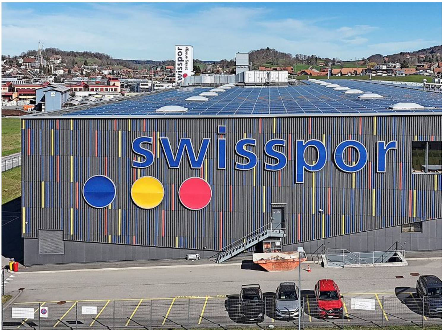
Lune des deux usines de Swisspor, à Châtel-Saint-Denis. Le responsable des sites romands du fabricant de matériaux d'isolation se prépare à annoncer, pour la fin avril, un relèvement de ses prix catalogue. Florian Cella
