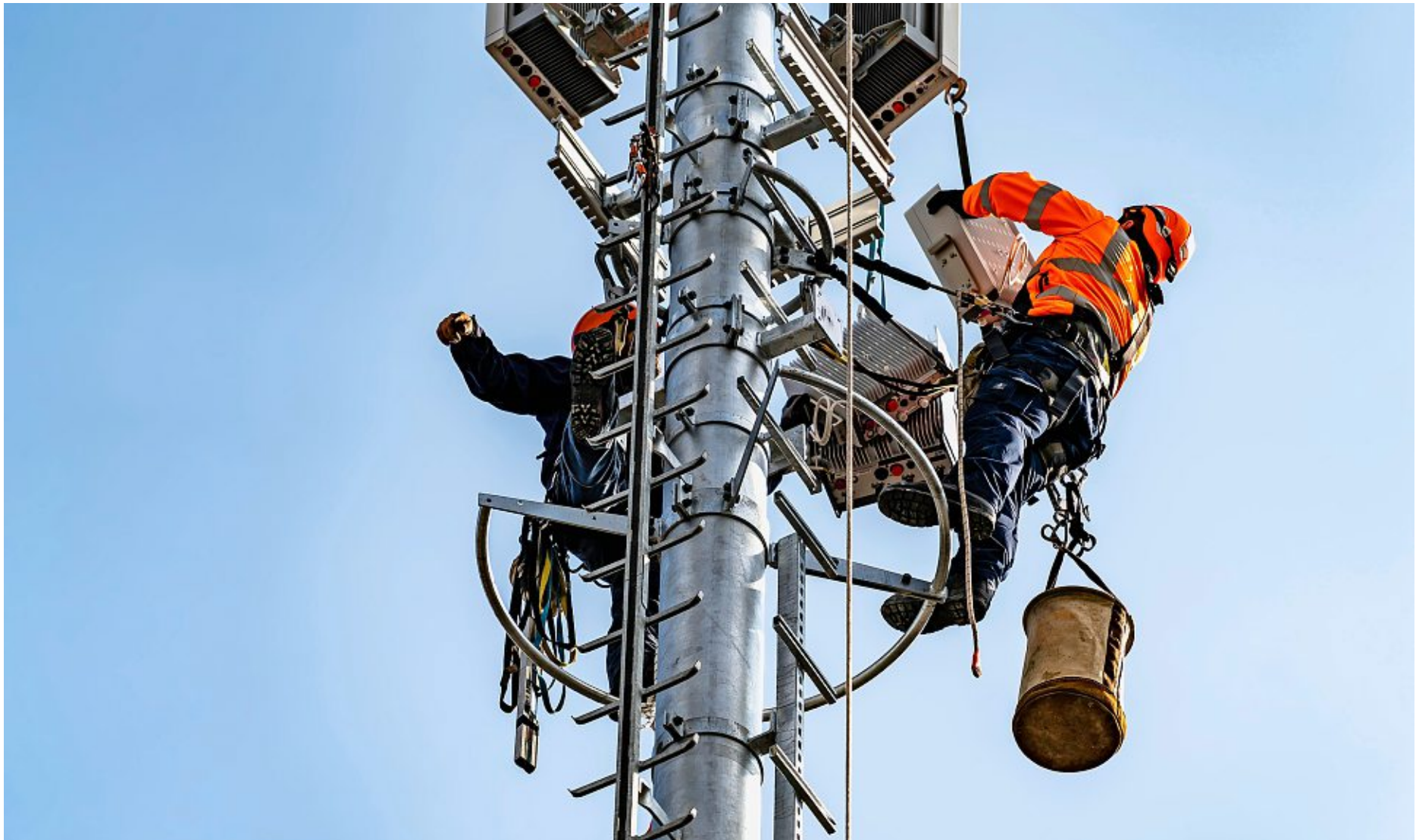
Wer hierzulande viele Angestellte beschäftigt, soll profitieren: Swisscom-Mitarbeiter installieren eine Mobilfunkantenne. Foto: Matthias Spicher
