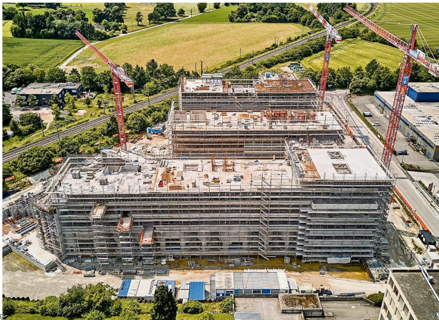
Les deux bâtiments du parc technologique Rubix ont pris forme dans la Zimeysa. Le gros œuvre de ce chantier innovant a été finalisé en neuf mois.
