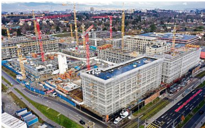
Les autorités et les développeurs espèrent faire du Rolliet un «quartier modèle». Ici, l'état du chantier début décembre 2025. plo.ch
