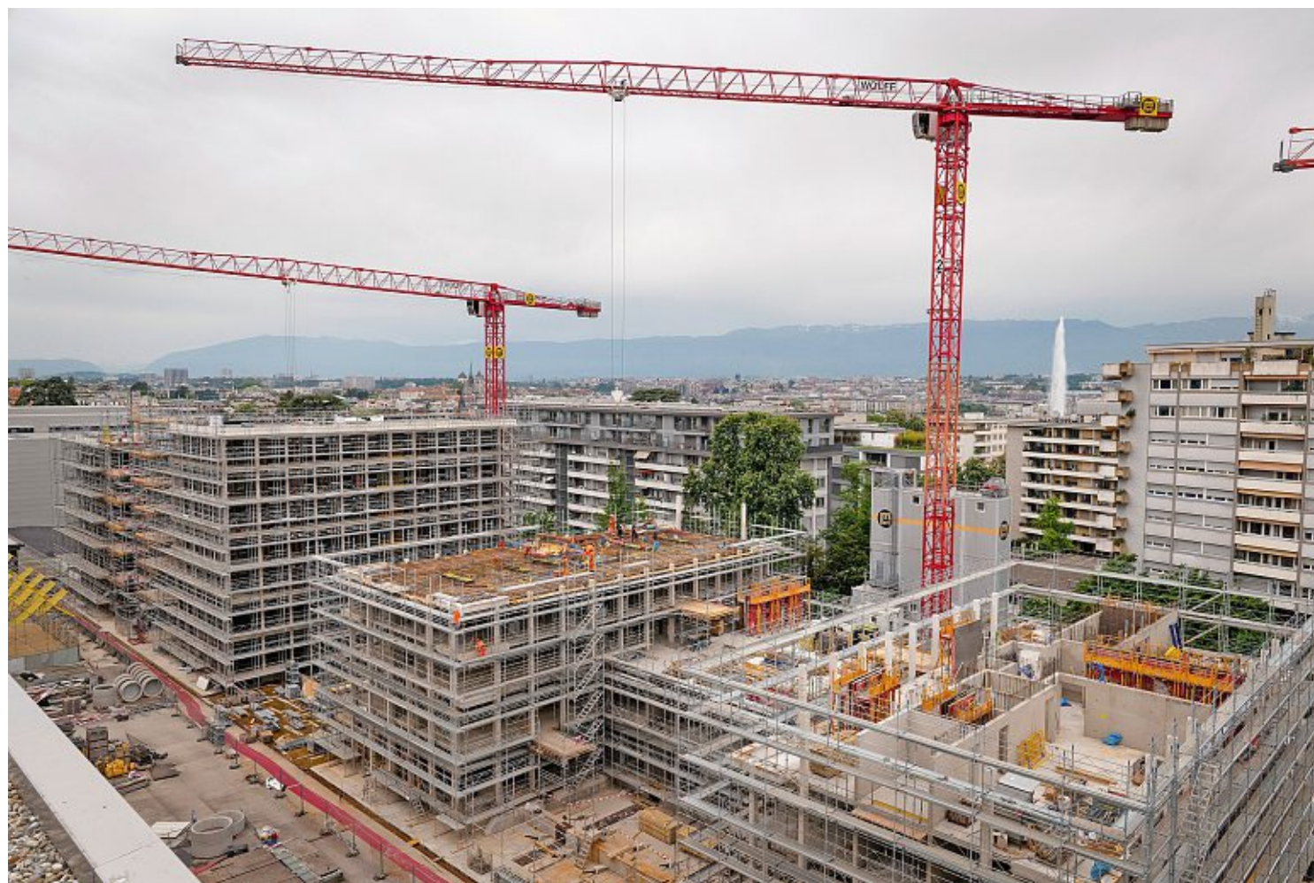
Ce bâtiment hors normes, composé de plusieurs structures, complétera les constructions du plan localisé de quartier. Laurent Guiraud
