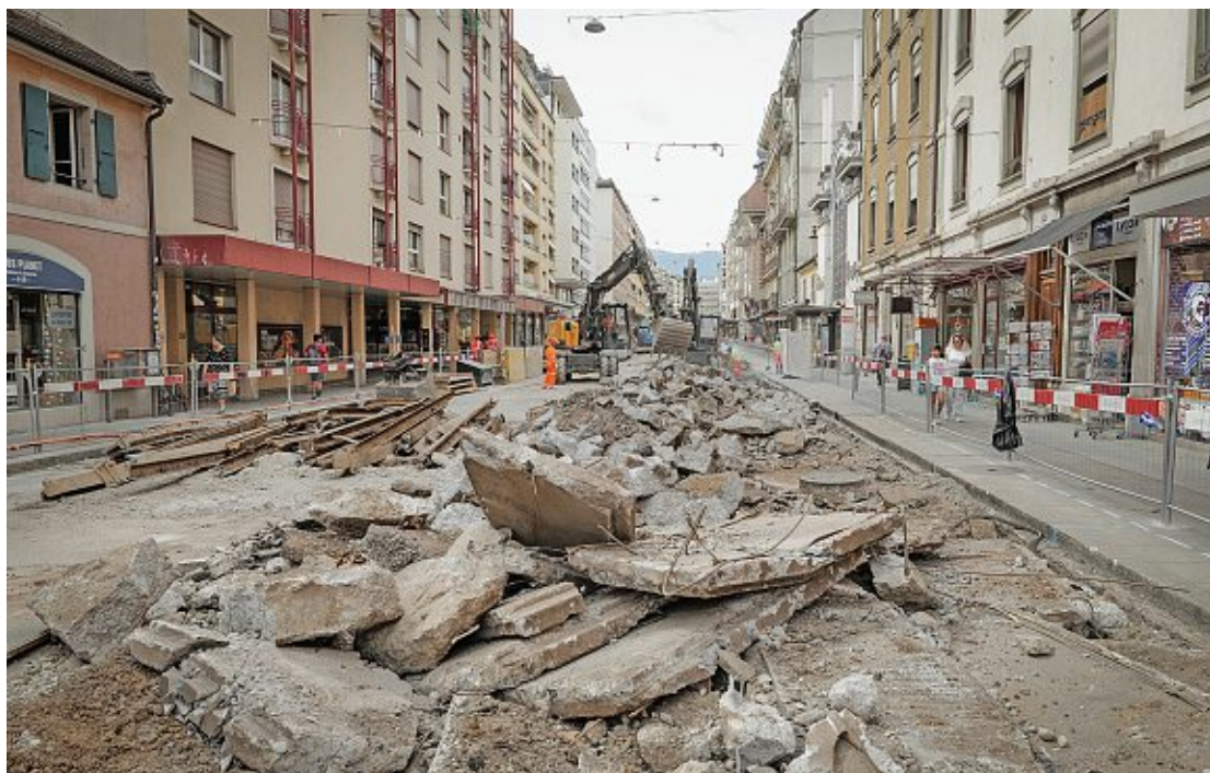
Le chantier, ici photographié au mois de juillet, prévoit le réaménagement de l'artère, ainsi que le remplacement des canalisations et des voies de tram. Il devrait s'achever en 2027. Laurent Guiraud
