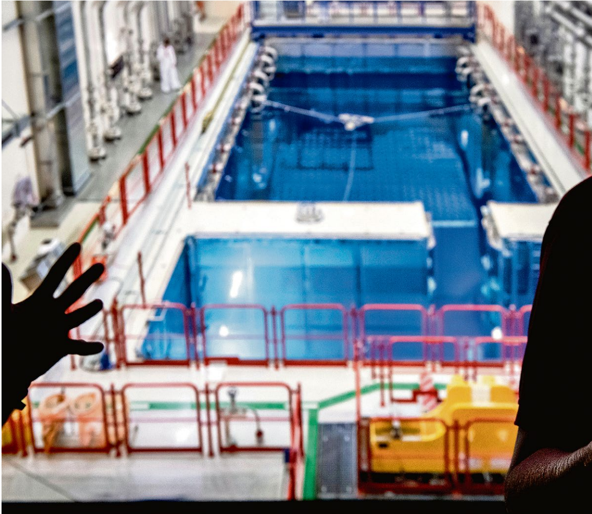
Le bassin de désactivation de la centrale. Il s'agit d'une piscine remplie d'eau où sont entreposés des combustibles usés et radioactifs.
