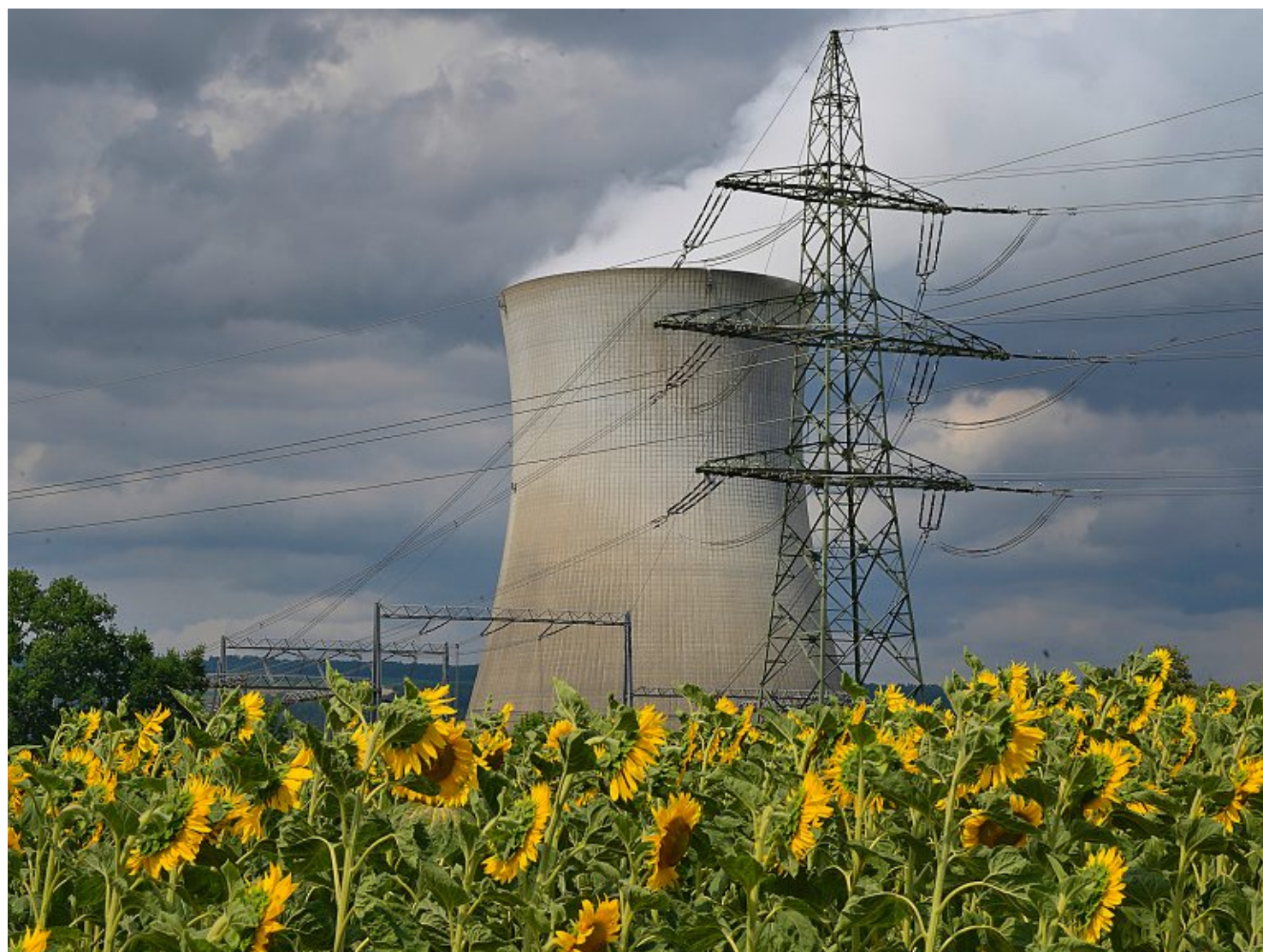
Das Kernkraftwerk Leibstadt: An dieser Stelle könnte gemäss der Axpo nach Betriebsende ein neues AKW gebaut werden. Foto: Madeleine Schoder
